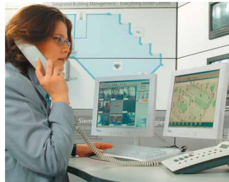
Con la soluzione Total Building Solution i sistemi di protezione incendio, antintrusione, controllo accessi, rilevazione presenze e tvcc sono gestiti da un'unica piattaforma di supervisione: Desigo CC
